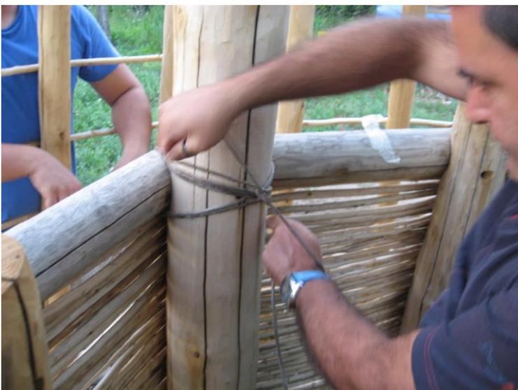
*Fig. 4 – Legatura delle pareti di tomagno ai pali portanti con specifiche corde*
